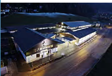
Das Vermarktungszentrum Rotholz erstrahlt in neuem Glanz. In der Baustufe II wurde der große Melkstall generalsaniert. Foto: Rinderzucht Tirol
