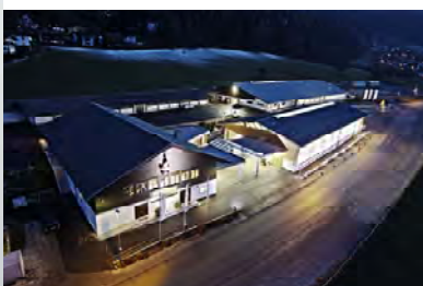
Sicherung des Viehmarktes Rotholz durch die umfangreiche Modernisierung des Standortes in insgesamt drei Bauphasen.
